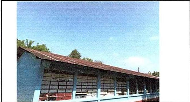
Foto 1: el techo del módulo 3 esta deteriorado y con goteras
