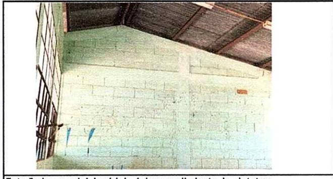
Foto 5: La pared del módulo 4 desprendimiento de pinturas.
