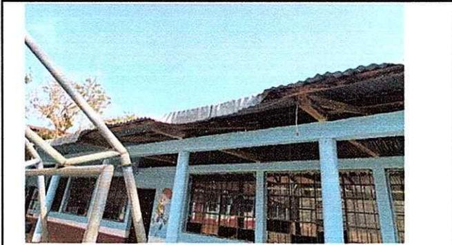
Foto 1: el techo del módulo 1 esta deteriorado y las costaneras de madera están podridas.
