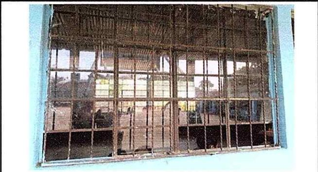
Foto 2: las balcones del módulo 1 desprendimiento de pinturas y los vidrios de las ventanas están quebradas.
