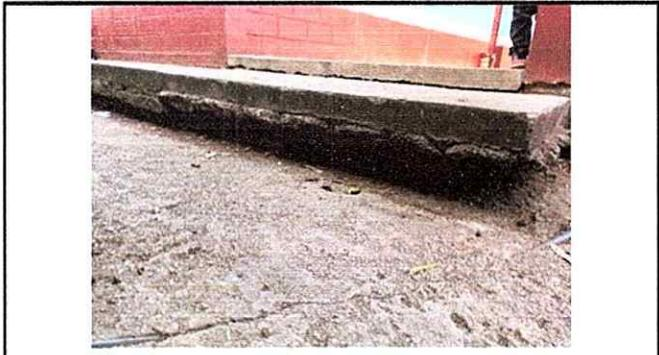
Foto 4: El piso del módulo 4 necesita muro para asegurarlo.
