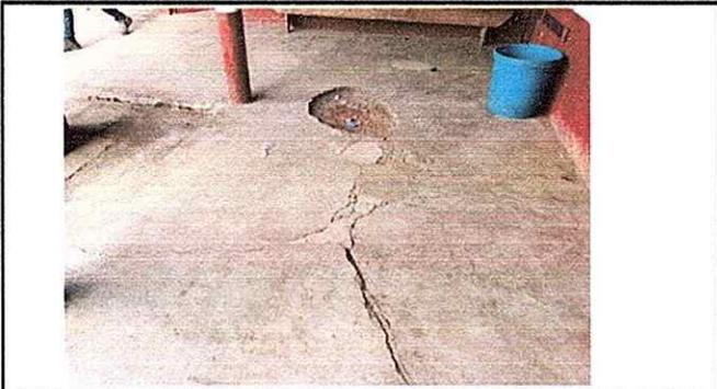
Foto 4: el piso del módulo 1 esta deformado
